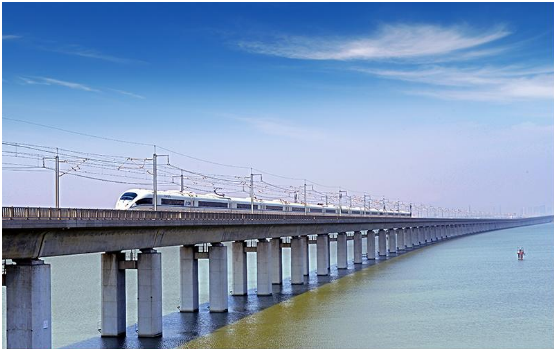
丹昆特大桥164.85公里——跨阳澄湖段
