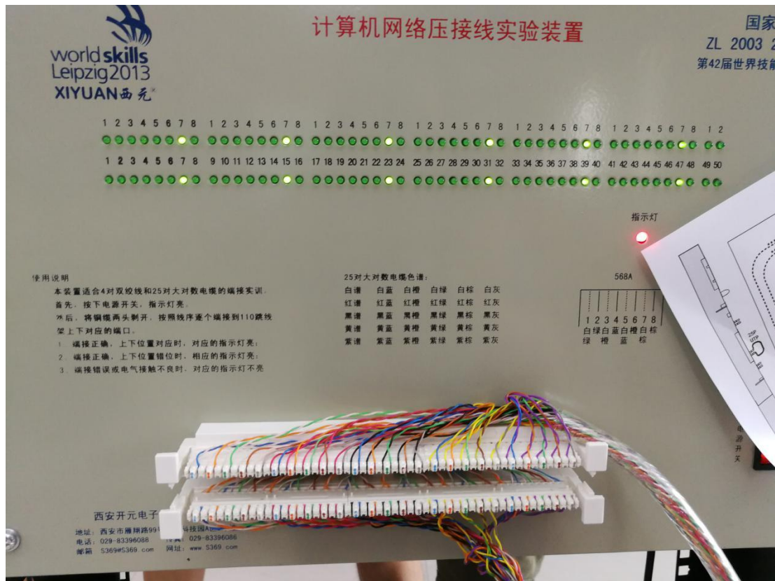
综合布线——大对数电缆端接实训
